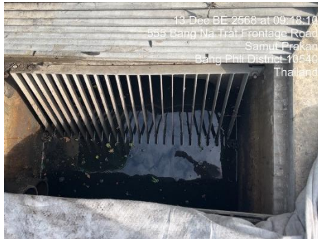
ภาพที่ 2.1-11 ตะแกรงดักมูลฝอยบริเวณบ่อพักน้ำทิ้ง สุดท้ายก่อนปล่อยออกนอกโครงการ
