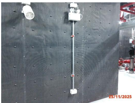
ภาพที่ 2.1-23 การติดตั้งแผ่นกันเสียง ภายในห้องเครื่องสูบน้ำ
